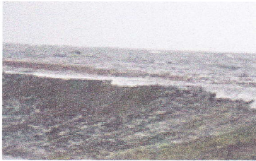
Sturmflut an der Küste: Das Wasser steht an der Oberkante des Sommerdeichs vor dem Langwarder Groden. Ist der an zwei Stellen geöffnet, wird der Groden überflutet. Fließt das Wasser zurück, könnte es im Fedderwarder Priel problematisch werden. Foto: Archiv
